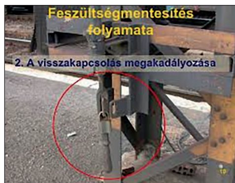
2. ábra: A visszakapcsolás megakadályozása (forrás: www.slideshare.net/magyarvasut/safety-under-ole )
