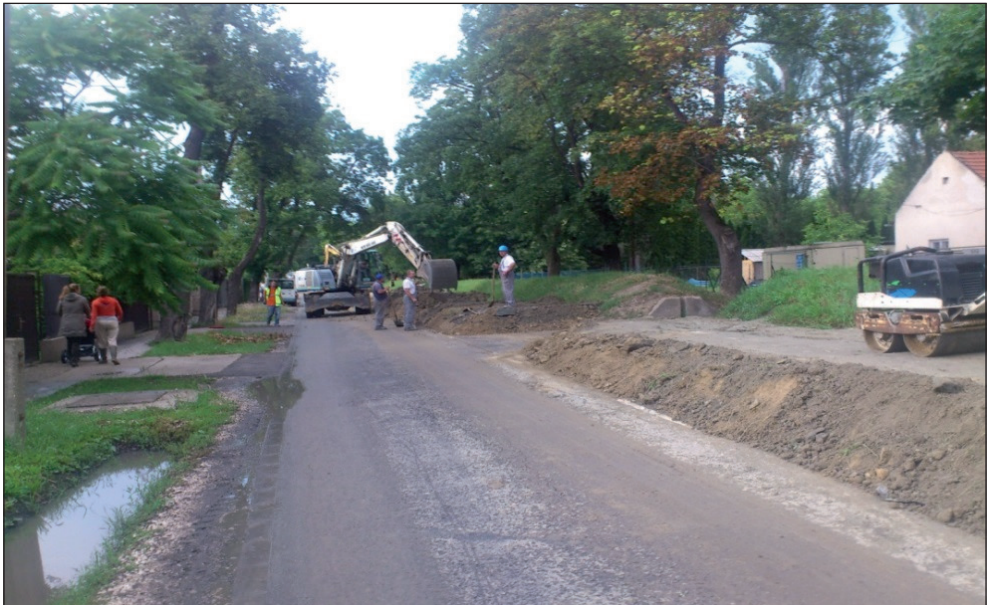
3. ábra: Védmű építése (készítette: Morvai Cintia, 2013, Római-part)
