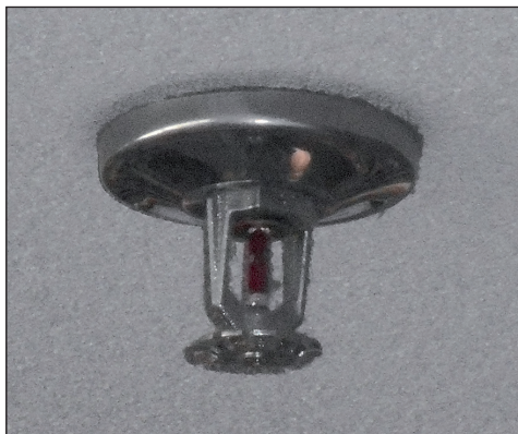
7. ábra: Spinklerfej (a szerző felvétele)
