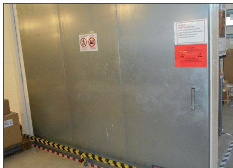
3. ábra: Tűzgátló kapu (a szerző felvétele)
