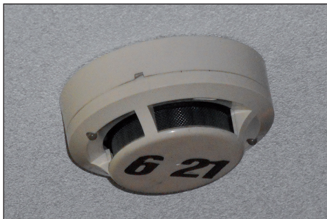
1. ábra: Tűzjelző érzékelő (a szerző felvétele)
