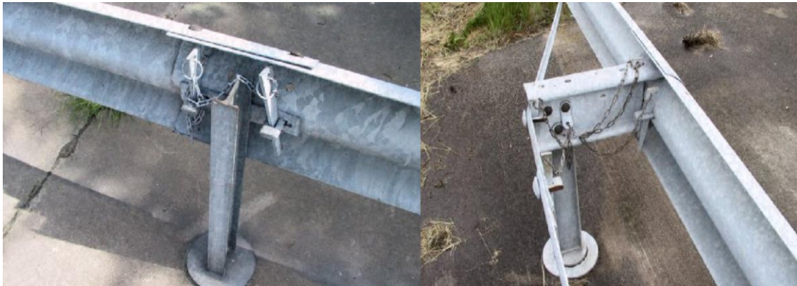
22. ábra. Speciális kialakítású, gyorsan felszedhető szalagkorlát, [77.]
